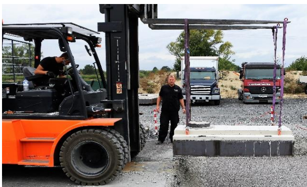
Transport und Montage PSK12
