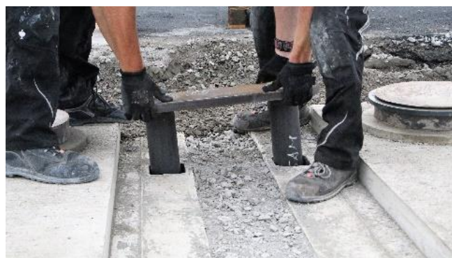
Verbindung der Betonteile mit Stahlklammern
