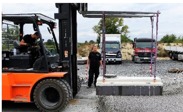
Absetzen der Betonteile
